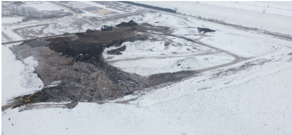
Recouvrement final de la pente nord
