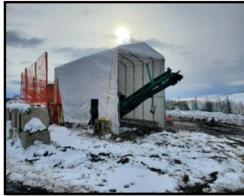
*Installation d'un abris au dessus du convoyeur pour essaie
