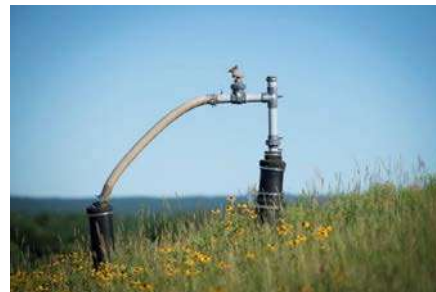
Puits verticaux (après que l'enfouissement dans une cellule soit complété)
