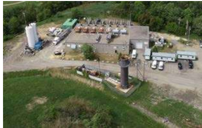
Production d'électricité grâce à une centrale située sur le site (revendue à Hydro-Québec)
