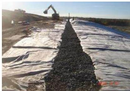
Tranchées horizontales (pendant l'exploitation d'une cellule)
